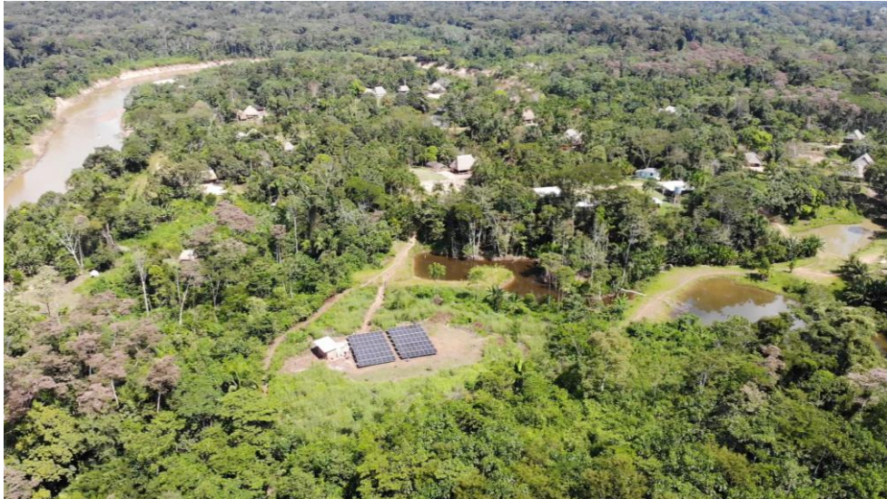
Figura 3. Sistema off-grid de energia solar instalado 20 .
